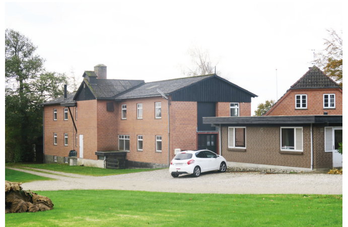
Midt i landsbyen ligger savværket med tilhørende bolig
